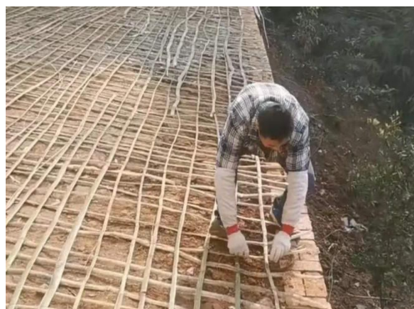
图2 竹条在填筑作业中的加筋应用
